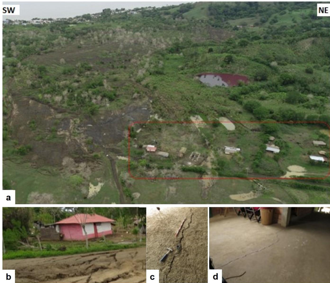
Figura 49. Afectación a viviendas por el proceso de propagación lateral a) vista general de las edificaciones afectadas por propagación lateral en inmediaciones a la corona del movimiento principal; b) c) y d) detalle del desplazamiento y formación de grietas en las edificaciones.
