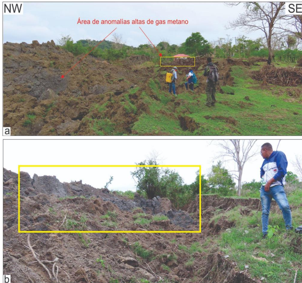
Figura 65. Área anómala con alta concentración de gas metano a) vista panorámica de la zona con grietas distensivas de tendencia predominante N30°-50°E, en la corona del movimiento en masa activo; b) detalle de la zona anómala con emanación de lodo.
